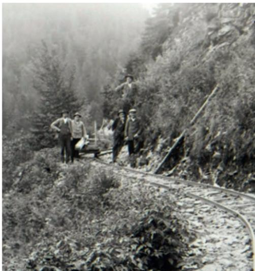
Um das Baumaterial zu transportieren, wurde eine 1300 Meter lange Bahn vom Rincken aus um den Berg gelegt. Die Loren wurden mit Menschenkraft den Berg hinaufgeschoben und -gezogen.
