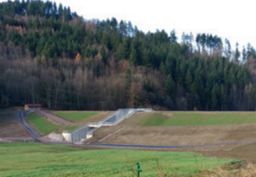
Resilienter werden heißt auf das veränderte Klima reagieren: wie zum Beispiel mit dem Bau des Hochwasserrückhaltebeckens im Bohrerbach oberhalb von Günterstal.
