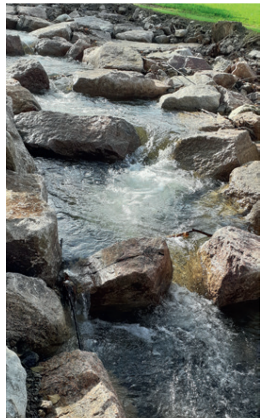
Mehrere Becken der Rampe
